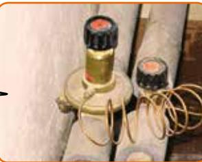
**СОЕДИНЕНИЕ КЛАПАНОВ ИМПУЛЬСНОЙ ТРУБКОЙ**
